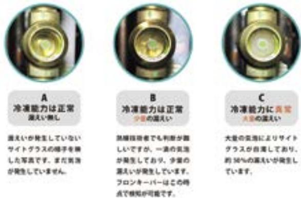
▲フロンキーパーは液管内（サイトグラス）に発生する気泡からフロン漏れいを検知する
