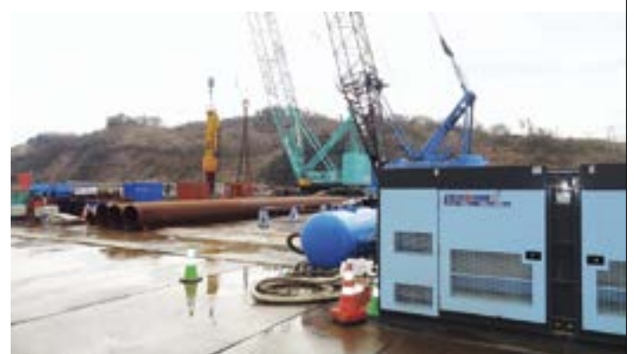
▲大河津分水路改修事業にて、地中を掘削するドリルの動力源として使用された当社のエンジンコンプレッサは日本最大級
