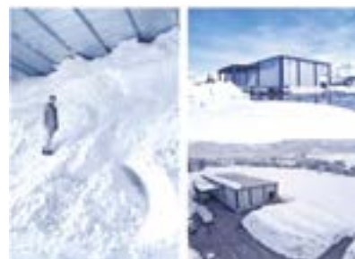
▲雪の冷熱エネルギーを利用してお米を低温で保管できる雪室
