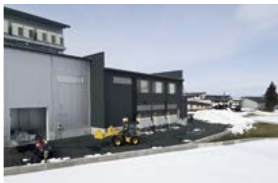
▲新社屋に隣接する雪温精米工場
