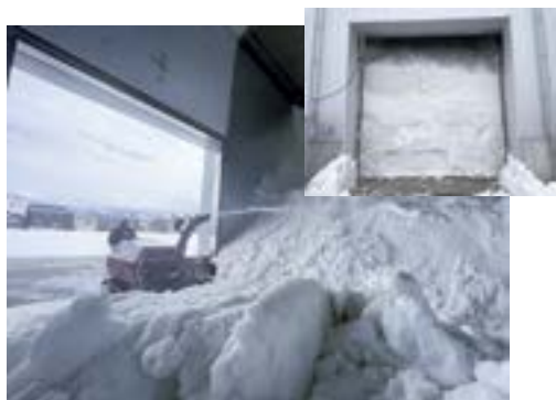
▲冬場の雪を蓄積し、雪冷熱として使用
