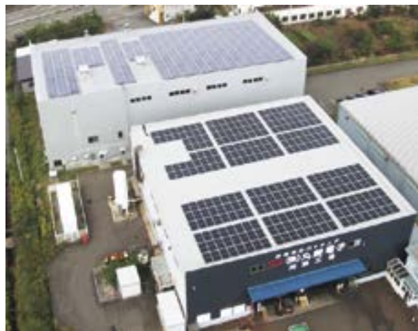
刈羽工場屋上に設置した太陽光発電パネル
