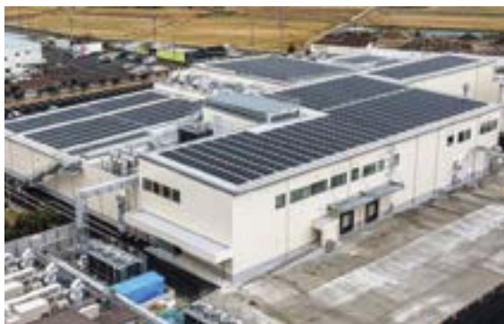
本社第2工場屋上に設置した太陽光発電パネル
