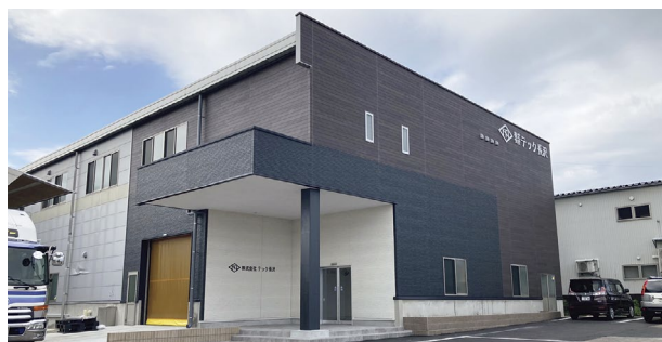
▲2023年10月に完成した本社工場
