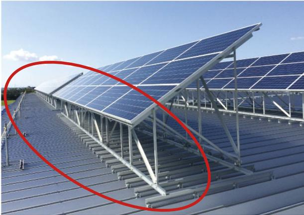
折板屋根に取り付けた太陽光パネルの架台
