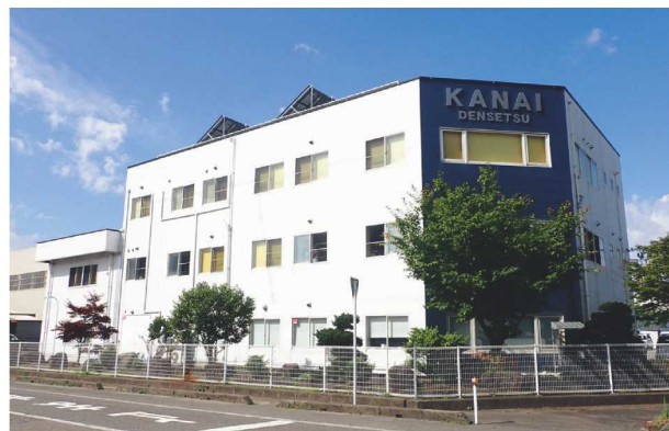
新潟市北区にある新潟支社
