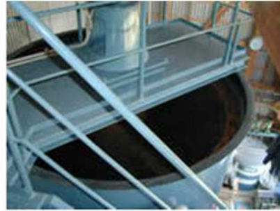
全自動排水処理設備の排水処理用薬品貯槽 全自動排水処理設備の沈降槽
