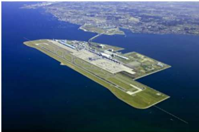
中部国際空港島建設工事
