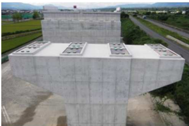
東海環状員弁大安高架橋北下部工事
