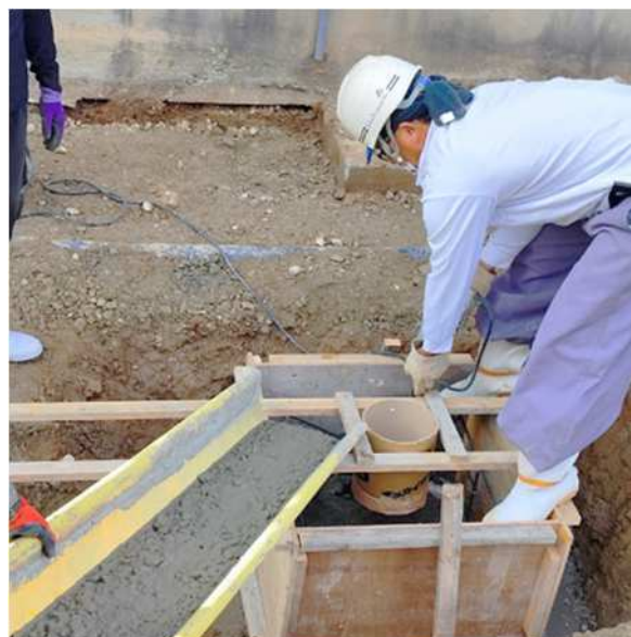
【コンクリート打設工事の様子】
