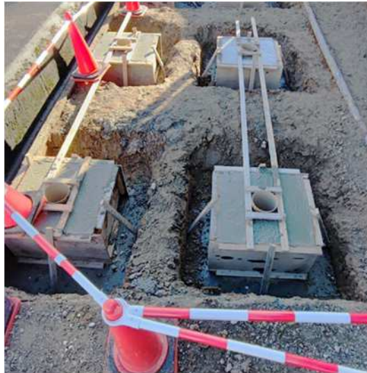
【土工事(掘削工事)の様子】
