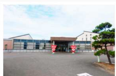
新潟市老人福祉センターいこいの家西川荘 空気調和設備改修工事 2021年度
