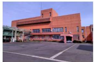
新津処理場機械棟他改修空調その他工事（1期） 2023年度
