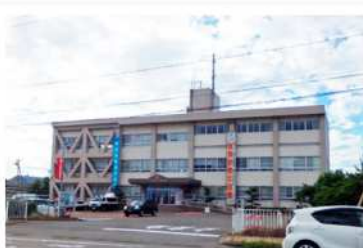
新潟県警察江南警察署 空調設備改修工事 2021年度
