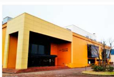
巻地区公民館・巻文化会館 空気調和設備改修工事（大宗・小川 特定共同企業体）
