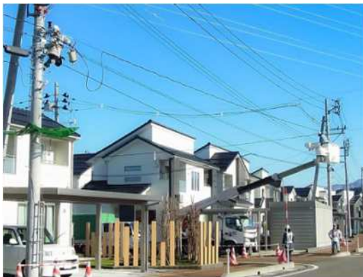
電力高所作業
