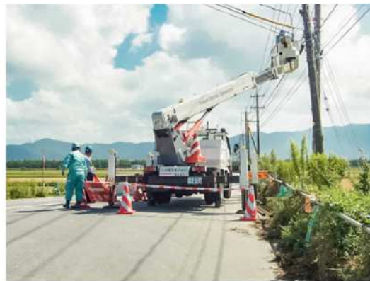
電力高所作業車
