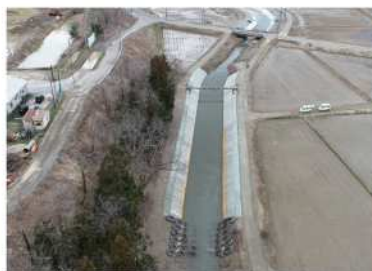
一級河川焼田川総合流域防災 (3か年) 護岸工事
