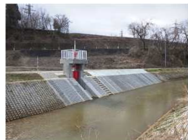
一級河川焼田川総合流域防災(3 か年)左岸樋管工事
