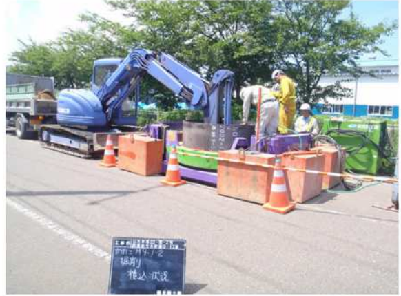
西福島汚水幹線工事
