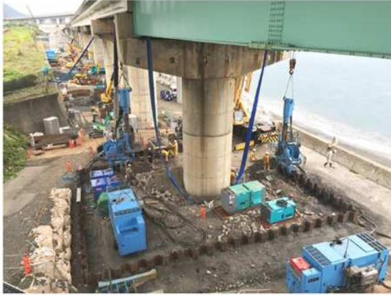
歌高架橋下部工事
