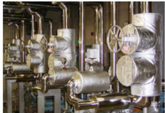
給水ポンプ廻り 仕切弁 逆止弁
